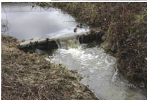
Slika 1 in Slika 2: Odbijač in prag na revitaliziranem Peskovskem potoku (Iztok Ameršek)
