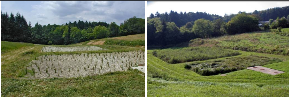
Rastlinska čistilna naprava v Sv. Tomažu tik po zasadnji z rastlinami (levo) in leto kasneje (desno) Vir: Ameršek, Sajovic, 2007.
