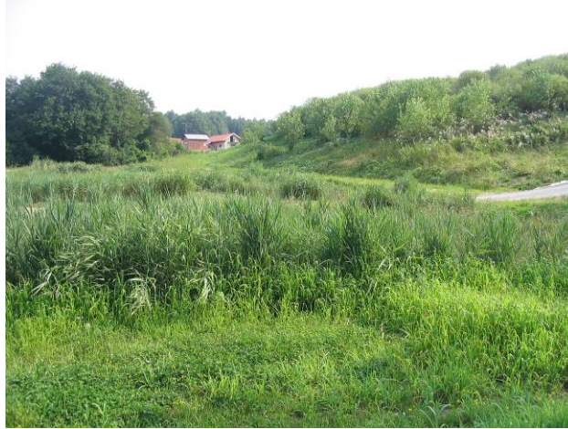
Rastlinska čistilna naprava za čiščenje izcednih voda iz deponije v Ormožu. Zgoraj desno vegetacijski pokrov čez stari del deponije (vir: arhiv Limnos)
