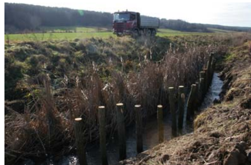
Slika 25. Regulirana struga Male Krke (levo), izgradnja bočne zajede na Mali Krki (desno) (Vir: arhiv Limnos).
