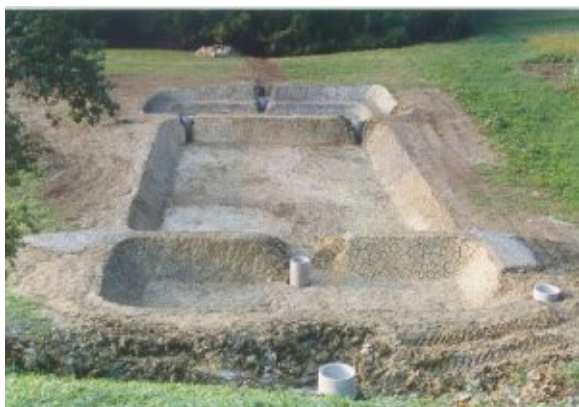
Izkop bazenov Vir: arhiv Limnos
