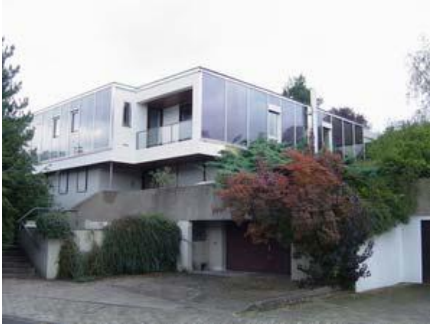
Slika 15: SSE vgrajeni v fasado hiše, Vir: Wagner & Co, Cölbe / ESTIF, http://www.ape.si/data/infolisti.pdf
