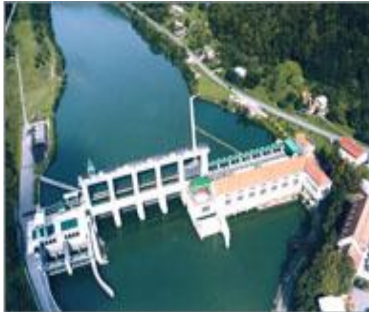
Slika 42 : Hidroelektrarna Fala – najstarejša na reki Dravi.
