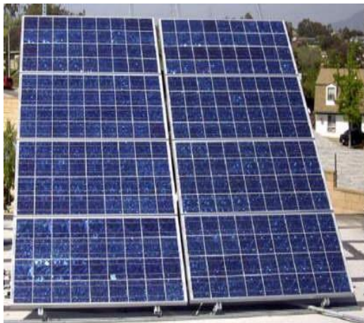
Slika 25 in 26: Sončni moduli zgrajeni iz sončnih celic Vir: http://www.focus.si/ove/index.php?l1=vrste&l2=soncna
