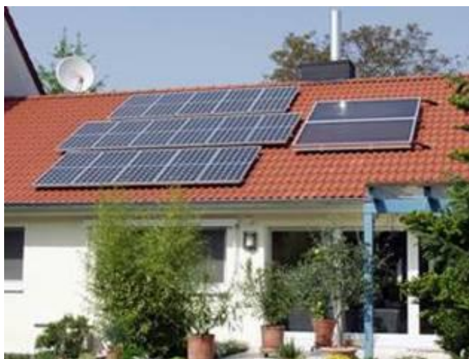
Slika 30: Sončne celice in sprejemnika sončne energije,
